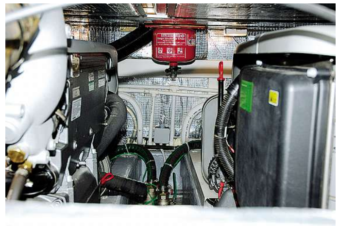
Beengte Verhältnisse im Maschinenraum, dennoch sind die täglichen Inspektionen ohne gymnastische Übungen zu absolvieren
